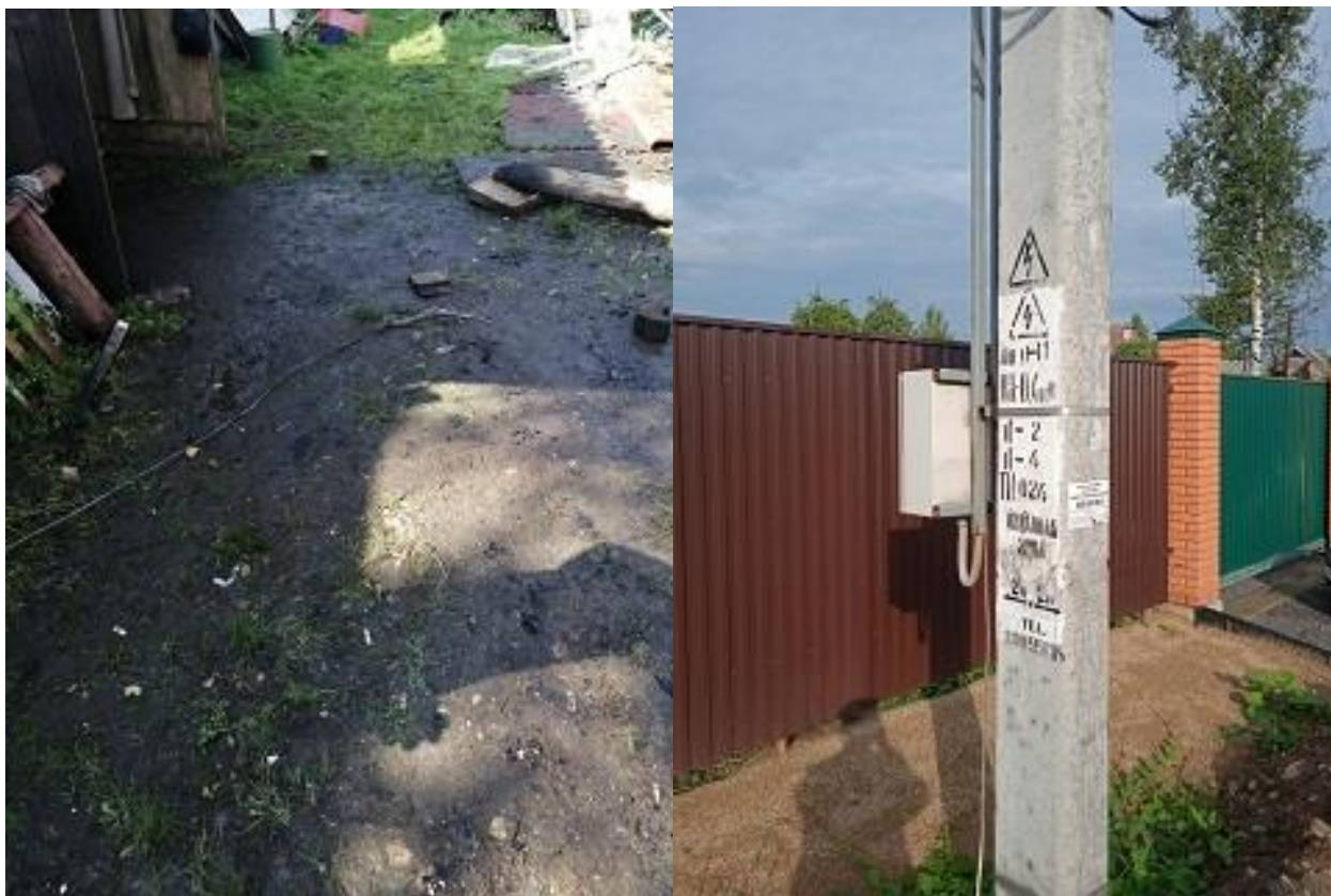
Место несчастного случая. Опора №11 ЛЭП.
