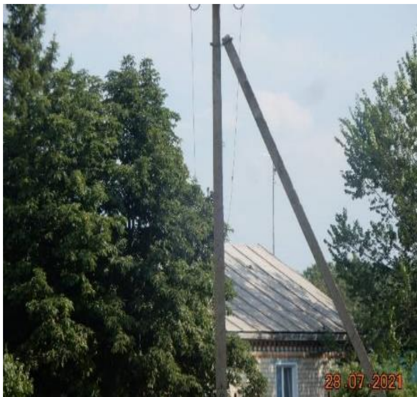
Место несчастного случая, пролет опор №№8-19/20-21 ЛЭП.
