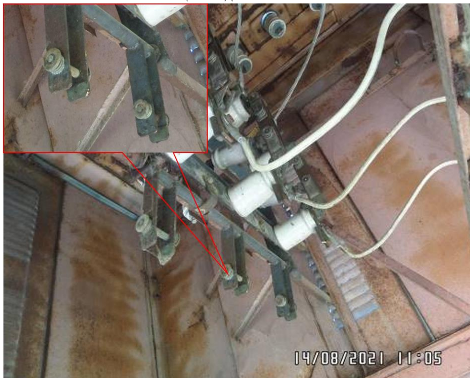
Токоведущие части ТП, находящиеся под напряжением (место приближения пострадавшего к токоведущим частям).
