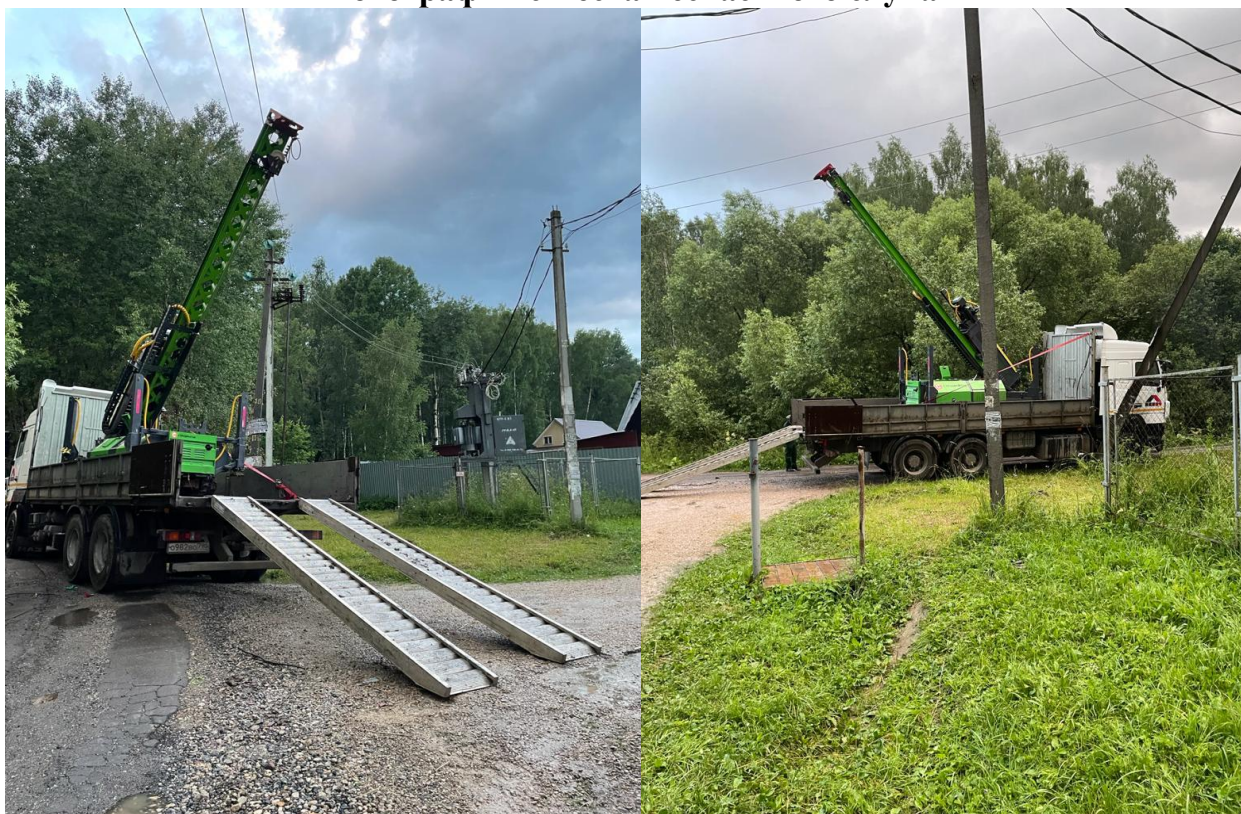
Свае-забойная установка на месте несчастного случая.
