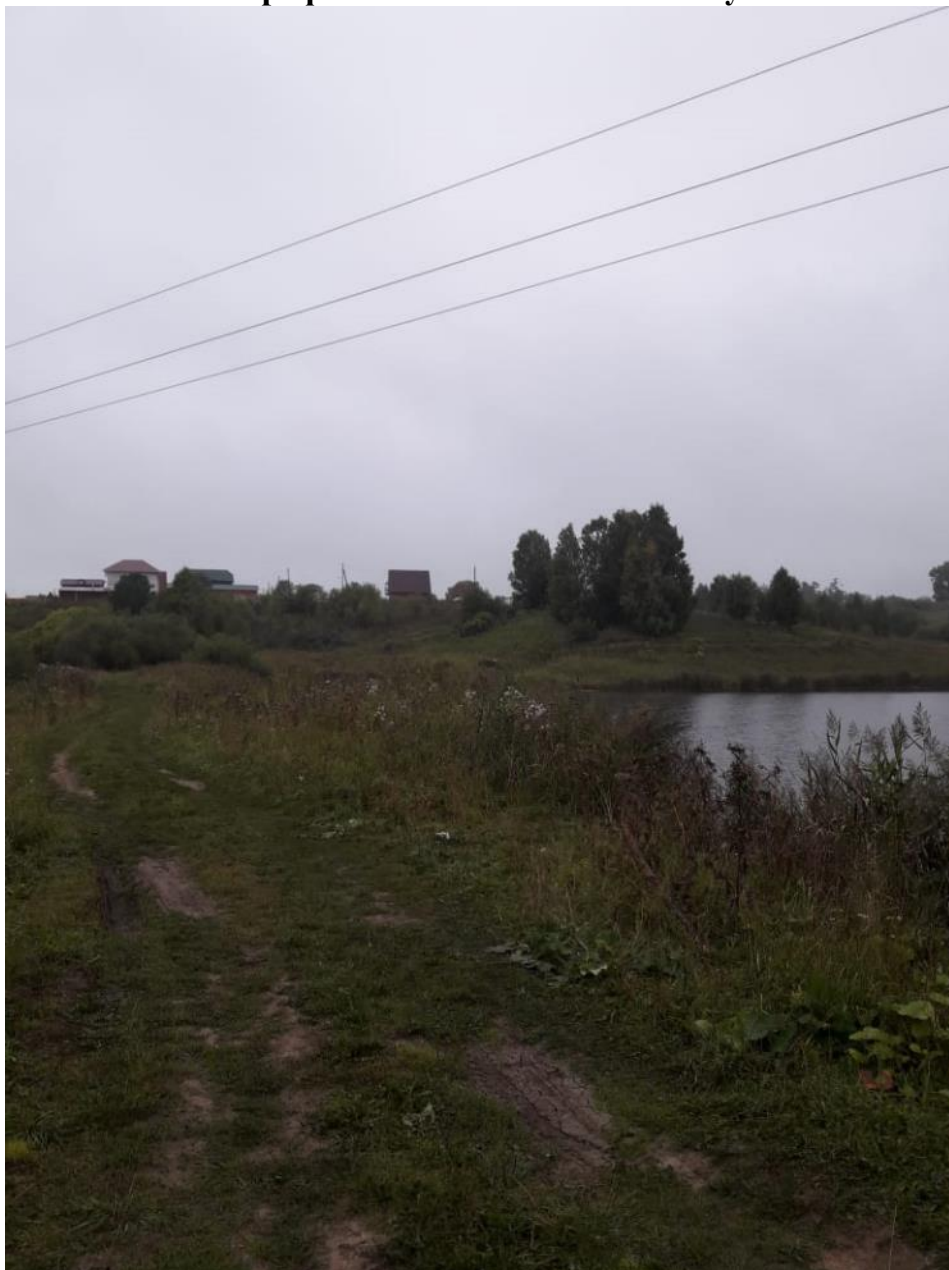
Место пересечения ВЛ и проселочной дороги проложенной по дамбе.
