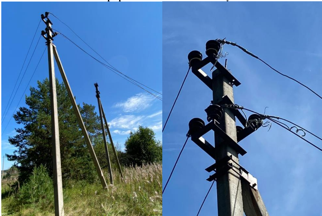
Опора №48 с демонтированными шлейфами.
